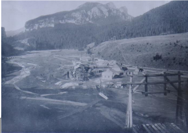
Bolboci, Antrieb- und Beladestation
